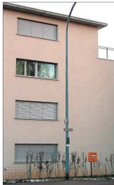
6.5b MFH mit teilweise geschützten Fassadenteilen.
