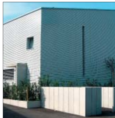
6.5c EFH mit nicht geschützten Fassadenteilen.
